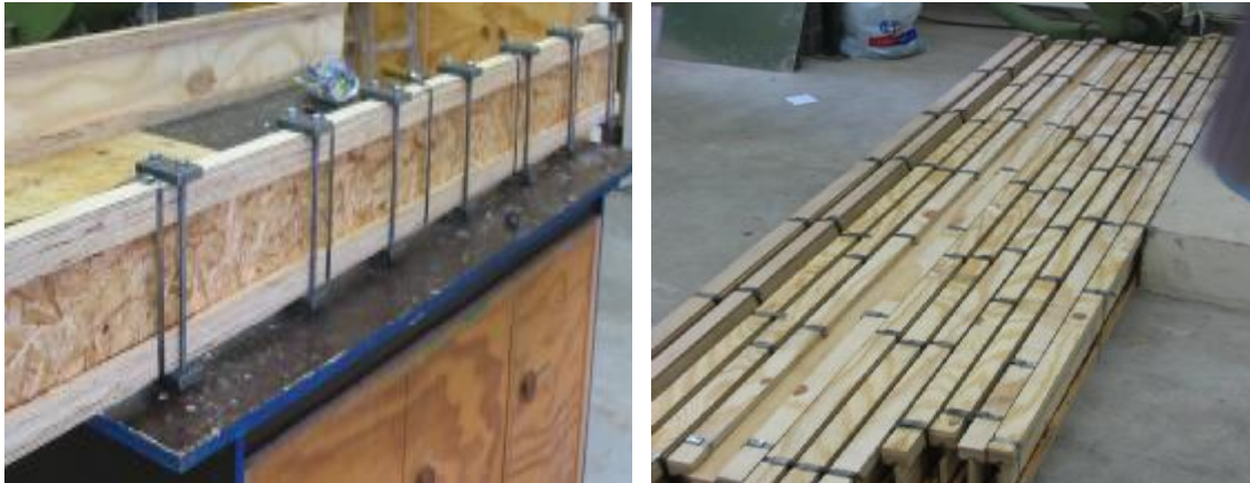
FIGURA 10 – Prensagem e amarração das vigas
